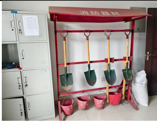
配电楼应急物资
