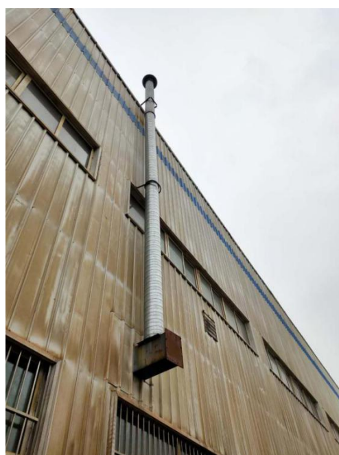
圆环链车间抛丸处理设施
